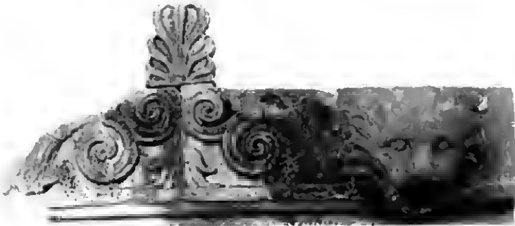
Fig. 113. — Chéneau inférieur de la Tholos n°40. Marbre. Gargouilles au milieu des pièces. Antéfixes sur les joints.
